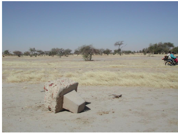
bornes déchaussées par l'érosion éolienne entre Diffa et Bosso
