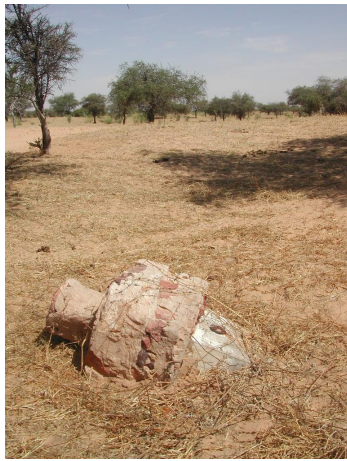
bornes déchaussées par l'érosion éolienne entre Diffa et Bosso
