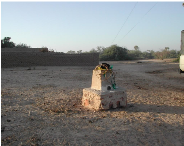
Geskerou : borne (presque) déhaussée par l'érosion éolienne
