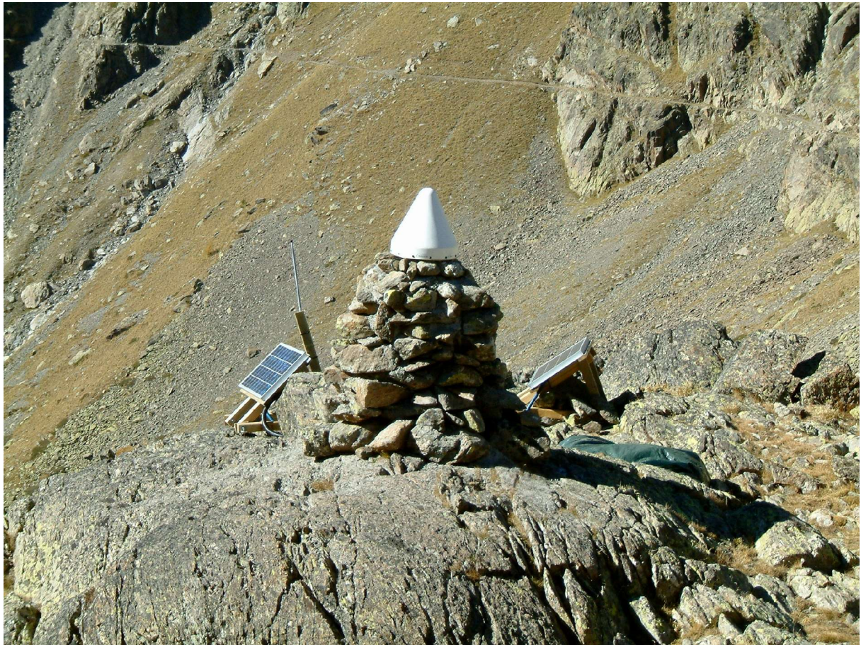
Photo n° 3 : Rabuons.(altitude 2551 m) Pour s'intégrer au paysage, il a été donné à ce pilier l'aspect d'un cairn.
