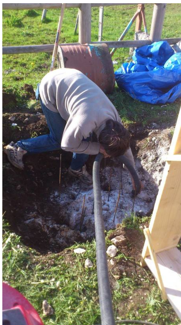
2. Utilisation d'un aspirateur pour nettoyage de la dalle rocheuse
